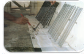
Application of Primer Coat
